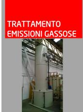
LE EMISSIONI GASSOSE SONO COMPOSTE DA IDROGENO ED OSSIGENO CON EVENTUALI TRASCINAMENTI DELLA SOLUZIONE ELETTROLITICA. L'INTERA LINEA DI DECAPAGGIO È DOTATA DI UN'ADEGUATA CAPPA DI ASPIRAZIONE CHE ASSICURA LA PRONTA EVACUAZIONE DEI GAS E DI UNA TORRE DI LAVAGGIO PER L'ABBATTIMENTO DI EVENTUALI TRACCE DI TRASCINAMENTI ACIDI.
